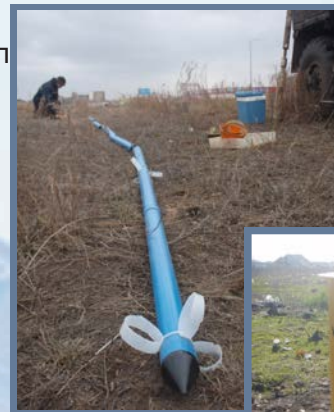
Трубы ПВХ из Германии с 0.2мм фильтром были незаменимы в тонкодисперсных грунтах
