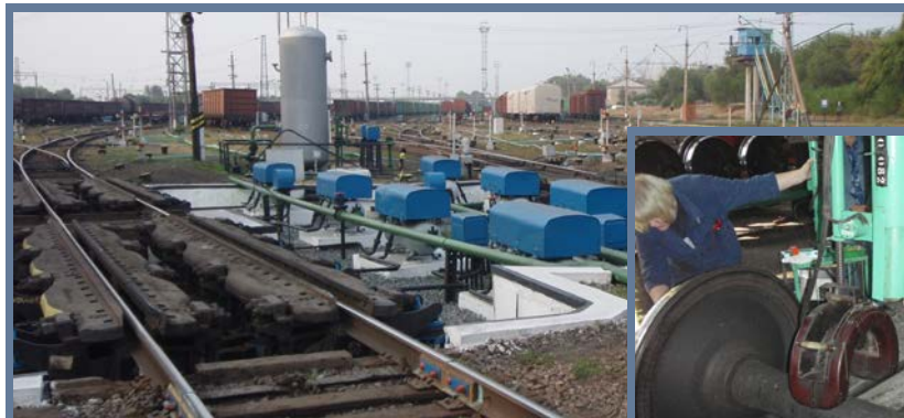
Тормоза горки сбора составов были основным источником шума в ночное время
