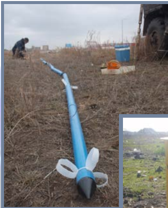
Законченный оголовок скважины
