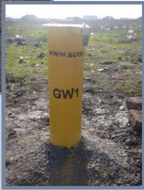
Законченный оголовок скважины
